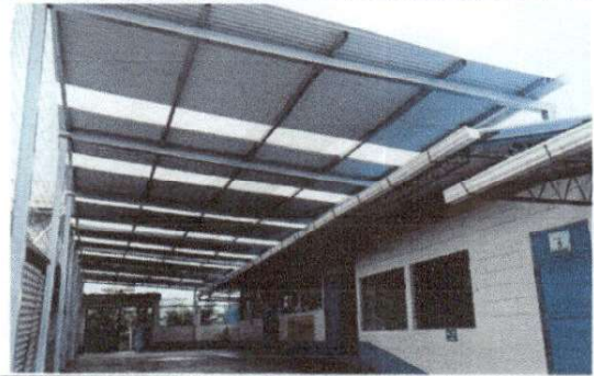
Foto 2: Lámina cambiada.
