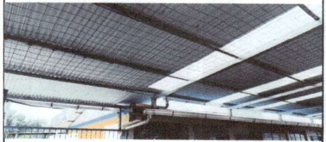
Foto 4: Techo de aula cambiado.
