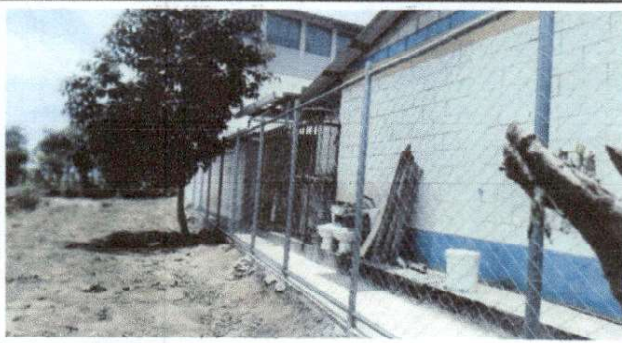
Foto 3: Muro perimetral restaurado.
